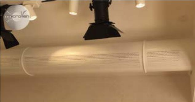
Le superfici interne molto lisce e senza giunzioni permettono di sfruttare al massimo l'alta velocità e l'alta induzione per dei locali fino a 10 metri d'altezza ed a 15 metri di lancio, dove quindi le velocità nel canale e nei fori non devono essere necessariamente spinte all'estremo.
